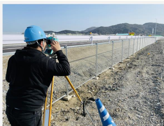
測量用の木杭
