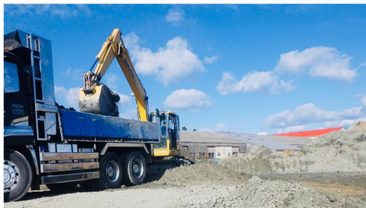
建設発生土の有効活用
