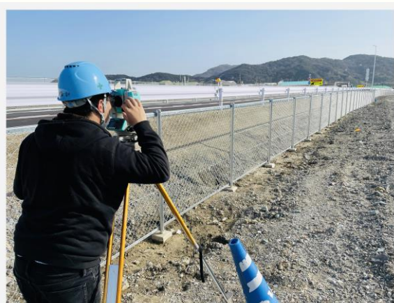
測量用の木杭
