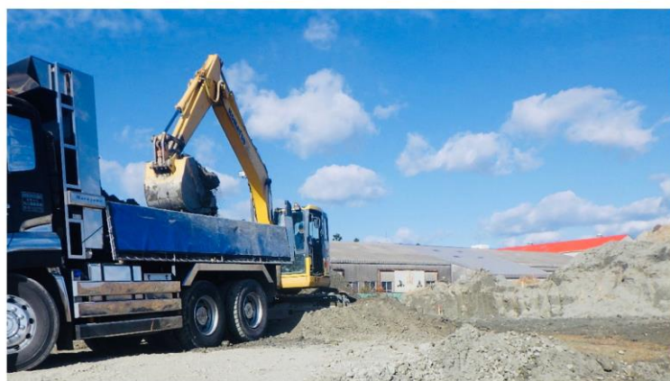
建設発生土の有効活用
